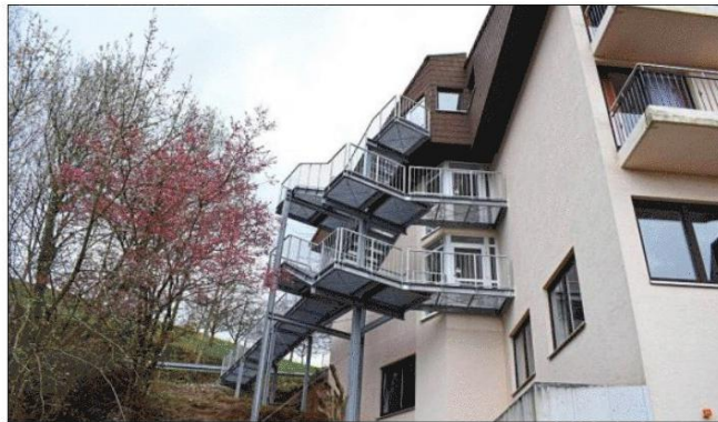
NEUE RETTUNGSTREPPE: In ihren Bau am Pflegeheim „Haus Straßburg“ in Sasbachwalden investierte der ASB Südbaden 200.000 Euro.
